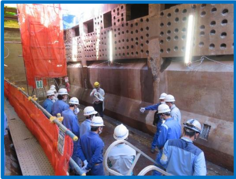
① 【水処理施設現場】
