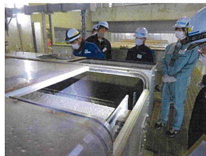
汚泥処理施設の見学
