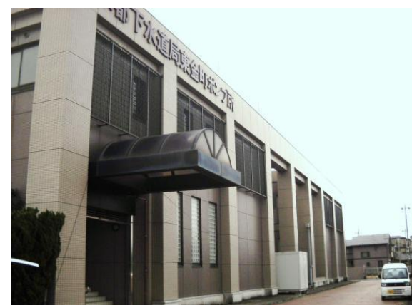
東金町ポンプ所
