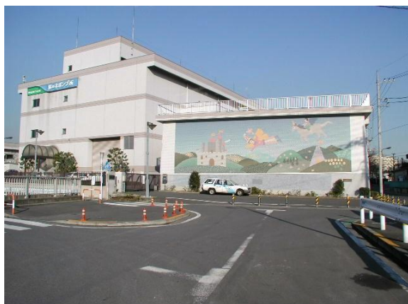
熊の木ポンプ所
