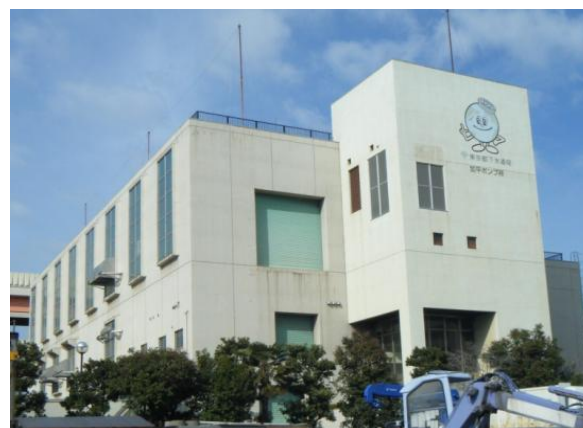
加平ポンプ所
