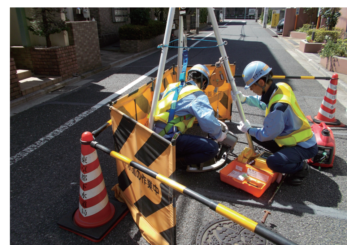
●下水道管の維持管理
