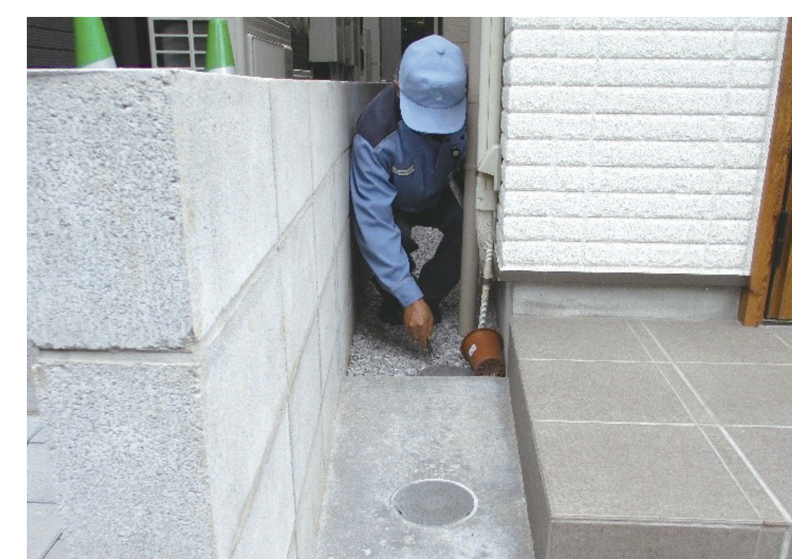
●宅地内排水設備の調査
